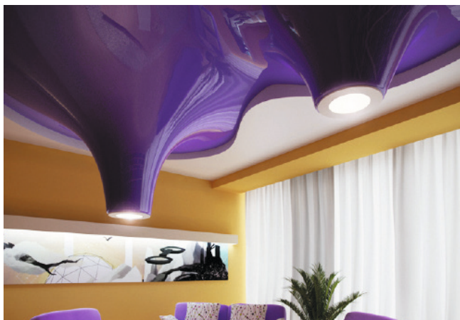
Многоуровневые потолки с конструкциями «конус», выполненные из глянцевого полотна.
