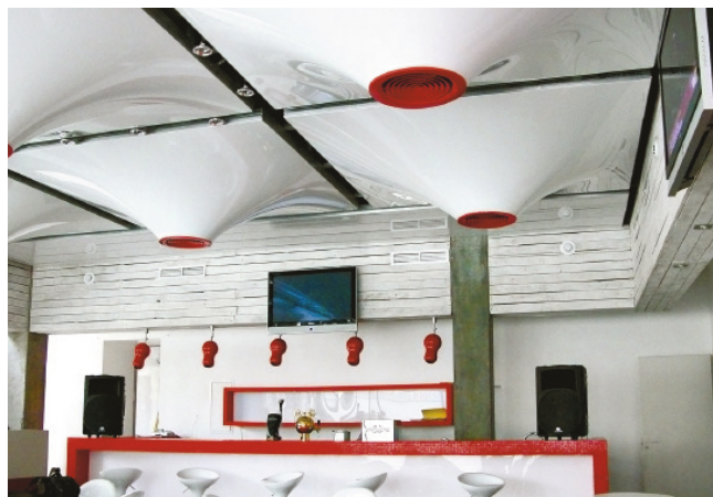
Многоуровневые потолки с конструкциями «конус», выполненные из глянцевого полотна.
