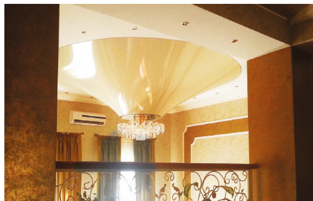
Многоуровневый потолок с конструкцией «Чаша», выполненный из глянцевого полотна.
